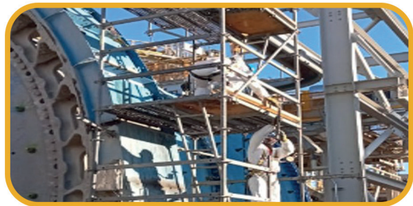
Montaje en molino SAG 01
