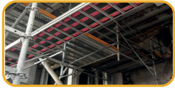
Montaje de andamios para cambio de liner chute de descarga de molino de bolas
