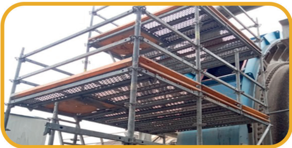
Montaje paraertura de ventanas en molinos SAG 03
