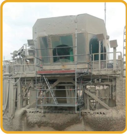
▲ Colgantes para facilitar trabajos de limpieza de cabina.
