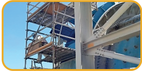
Montaje de nadamios lado de descarga del molino SAG 1
