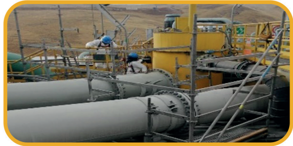
Montaje de andamios para cambio de spool molienda flotación
