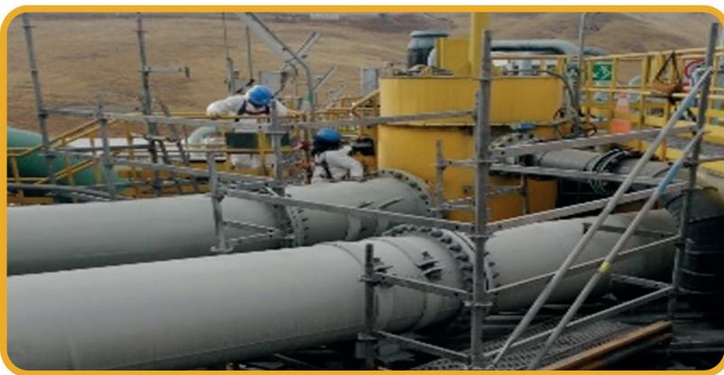
▲ Andamio colgante en puente grúa para reparaciones de bussbar.
