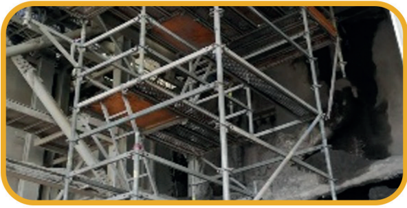
Montaje de andamios para cambio de liner chute de descarga de molino de bolas
