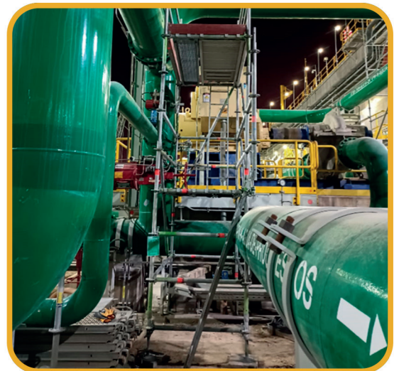
▲ Montaje de andamios colgantes al interior de tanques de remolienda para parches por fisuras internas.
